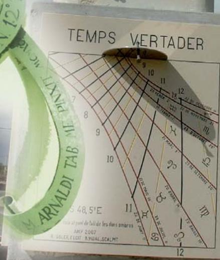
À Majorque, un cadran polyédrique bifilaire réalisé par Rafael Soler à la gloire des marins du village de pêcheurs de Cala Figuera. Ce monument comporte trois cadrans solaires verticaux déclinants ; l'heure solaire y est indiquée par l'intersection de l'ombre du style incliné et de la couronne horizontale.
